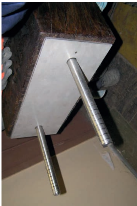
Plieninės plokštės ir strypų montavimas.
